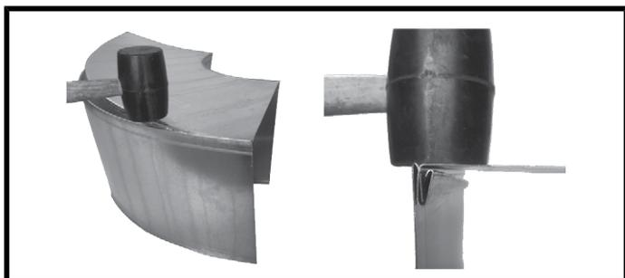
**4. Выровняйте торцы собранного воздуховода так, чтобы они были в одной плоскости. Установите предварительно собранные фланцы на торцы воздуховода с двух сторон.**
